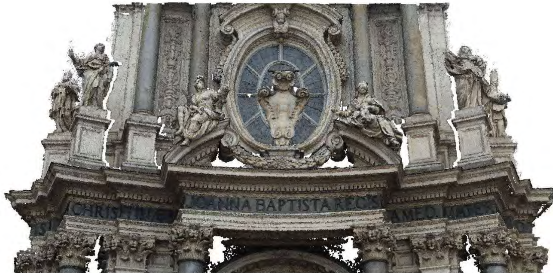
2017, RILIEVO LASER SCANNER DELLE FACCIATE DELLE CHIESE GEMELLE IN PIAZZA SAN CARLO A TORINO
