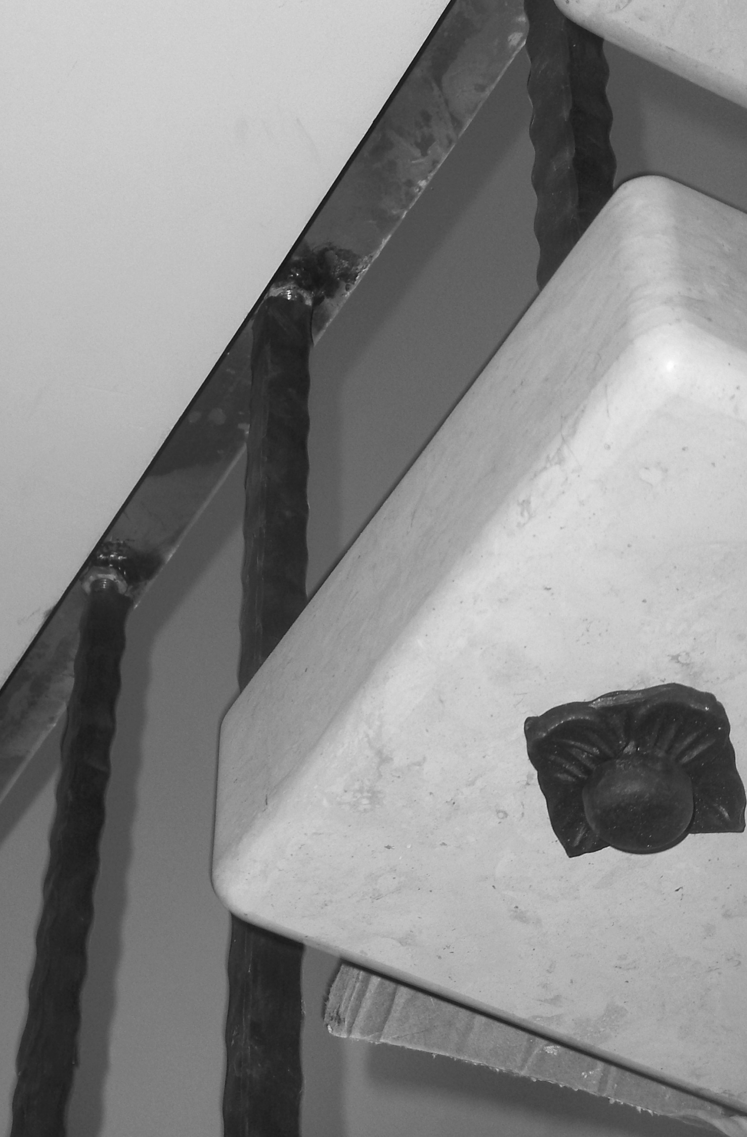
VILLA PRIVATA A MONTECARLO, RISTRUTTURAZIONE E ARREDAMENTO
